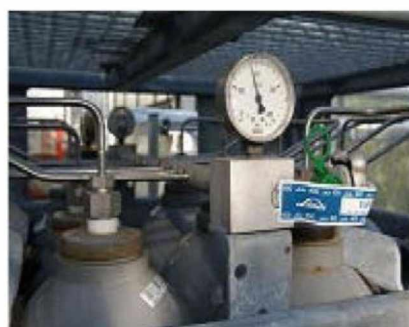
Фото 3: Расход можно проверить и определить по давлению в баллоне.
